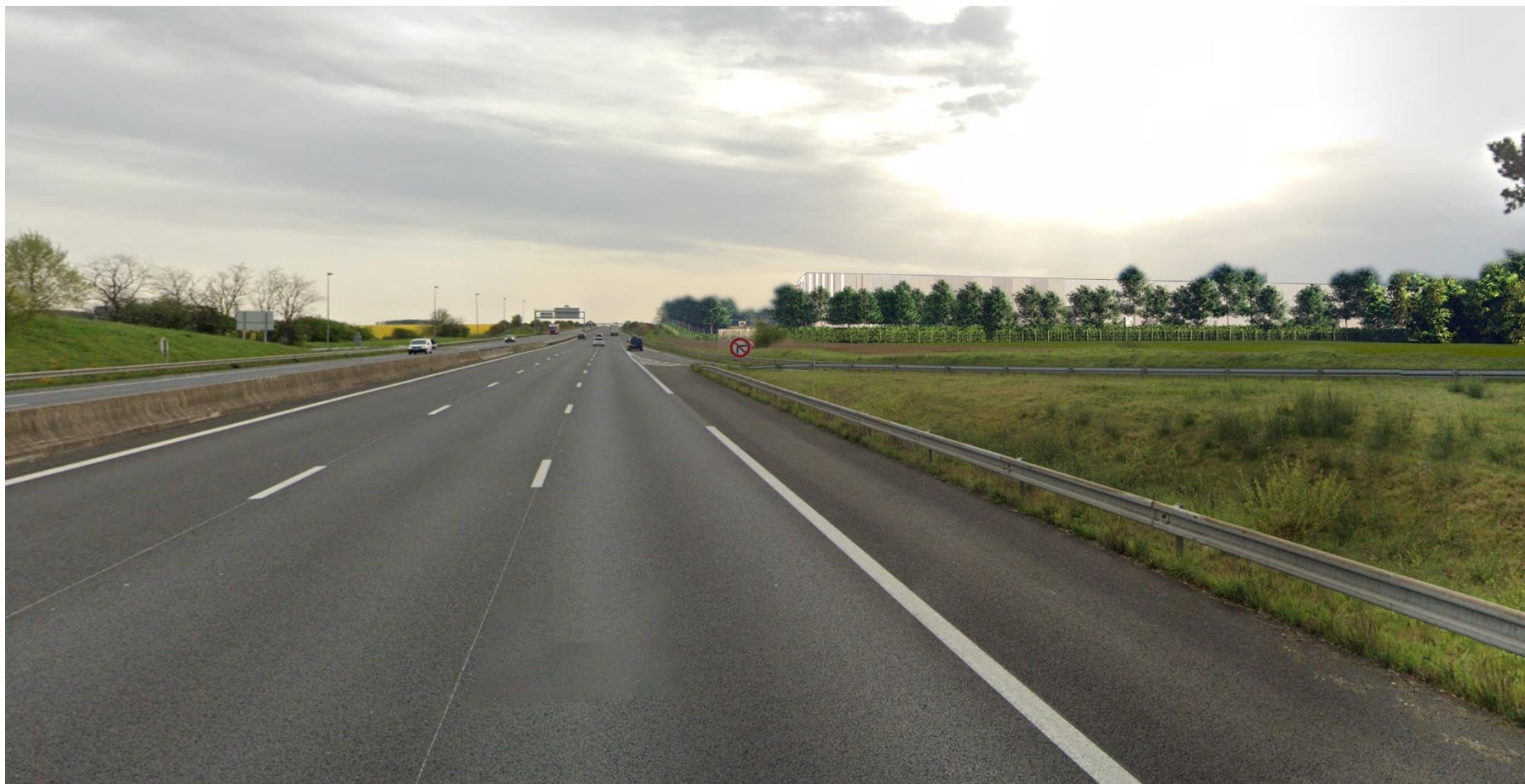
① Insertion Ouest : Autoroute A10 en direction de Blois. DNS
