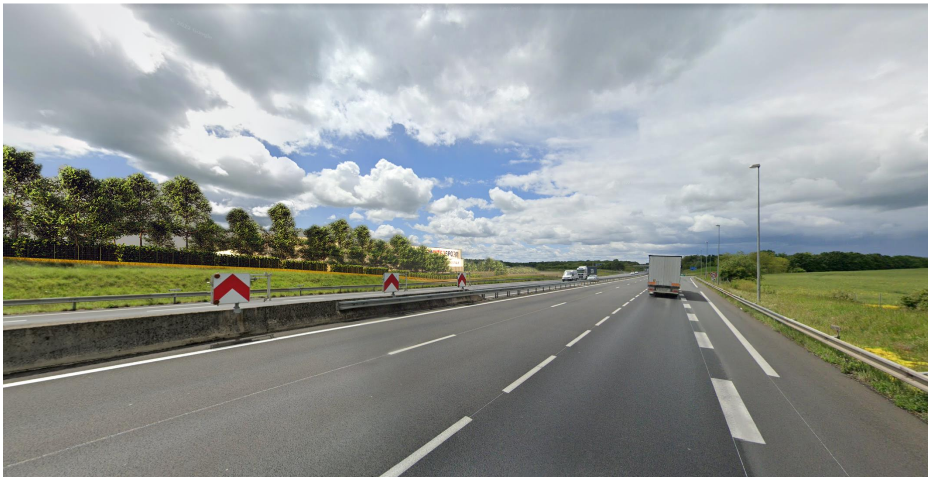
① Insertion Est : Autoroute A10 en direction de Tours
